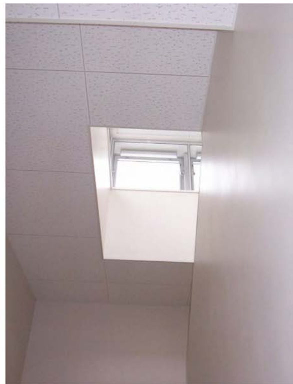
図10 階段室の換気用高窓
