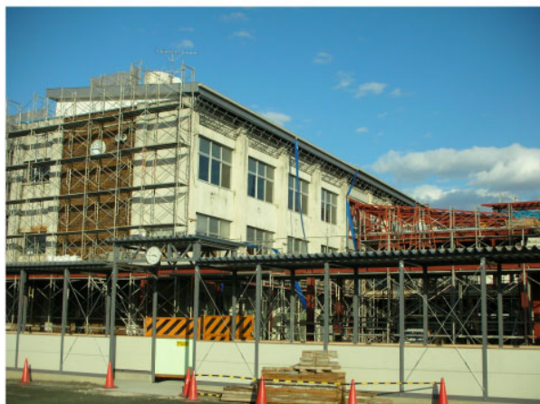
空気式太陽熱集熱システム、遮熱のため置き屋根の工事中。(北棟)
