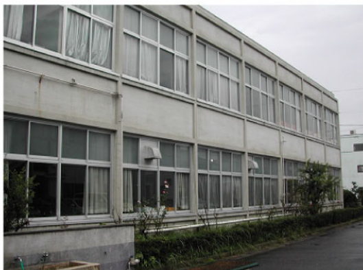
改修前 南棟南側外観
