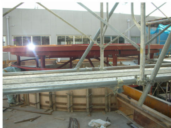
増床する環境学習センターに自然光を取込む高窓。
