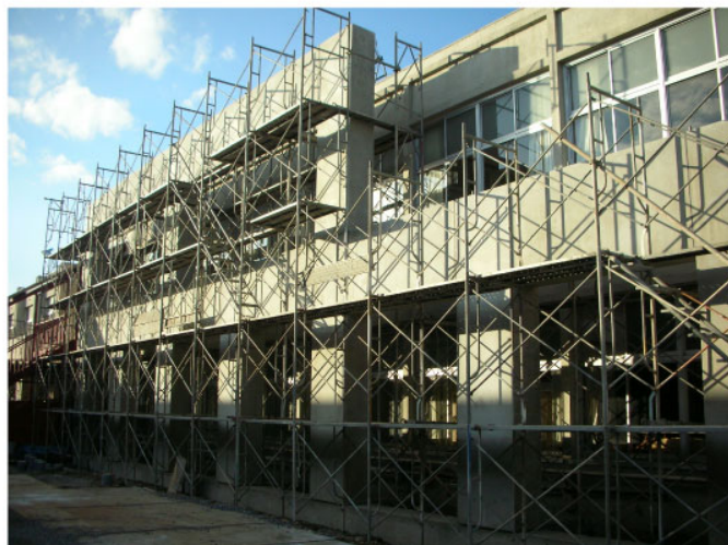
改修中 南棟南側外観
