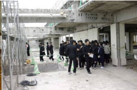
改修工事の現場見学 工事中の現場を見学して、校舎の特性を学ぶ。
