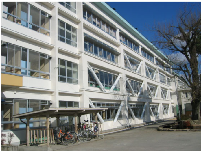
改修後 北棟西の南側外観
