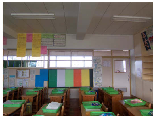
教室と廊下の間仕切りは、ガラスをペアガラスへ変更するとともに、塗り替え、一部引き戸を新設。
