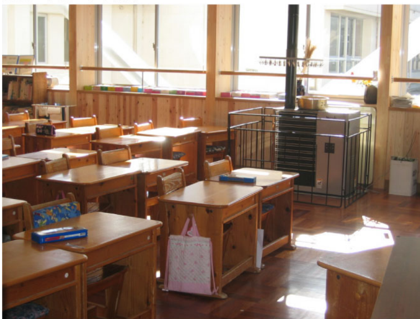
普通教室は、灯油ストーブから暖房能力が2.8kW～13.9kWのペレットストーブに変更。
