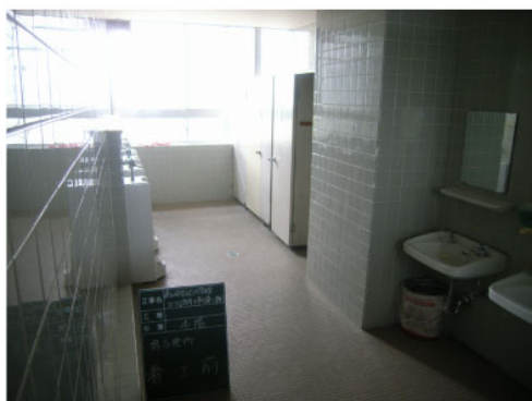
改修前の便所
