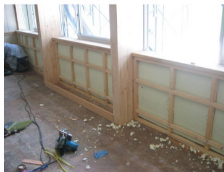
建物の熱性能の向上のために、内断熱とペアガラスサッシへ改修。
