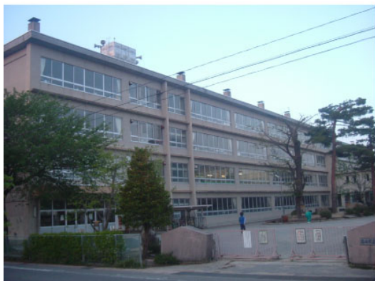
改修前 北棟西の南側外観
