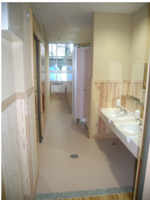
各階の便所は、節水型の便器への入れ替え。内装は、腰壁は、厚さ12 ミリ の板貼り。腰から上は、ボード下地の上に土壁塗り仕上げ。
