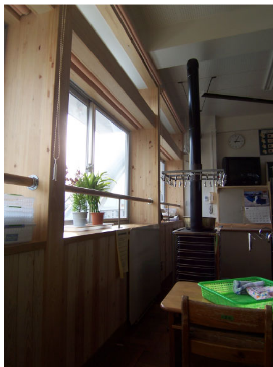
内断熱改修と合わせて、内装を木質化。カーテンボックスを兼ねた室内側ライトシェルフ。
