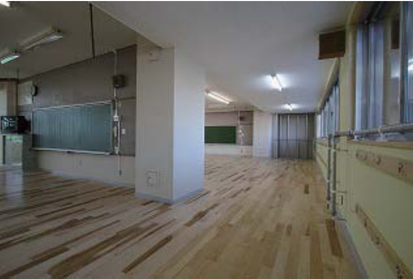
教室を学年ごとにまとめたうえで、耐震フレーム、廊下との間仕切りの撤去することで、通風を促進して夏の環境を改善、合わせて学習エリアを拡大。
