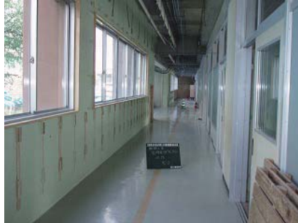
北側外壁はウレタンを30mm吹き付けて断熱。廊下に扉を設け、学年・暖房時の区画に利用。
