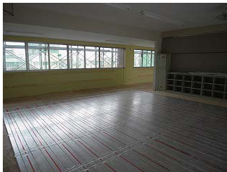
床材の下に施工した温水配管パネル。
