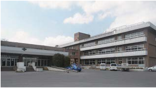
改修前 昇降口と校舎南側外観
