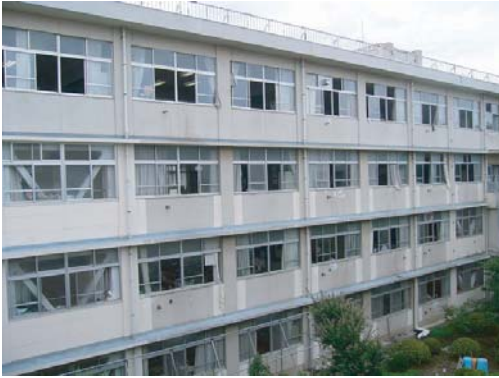
改修前 校舎南側の外観
