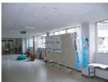
改修前 昇降口前の廊下
