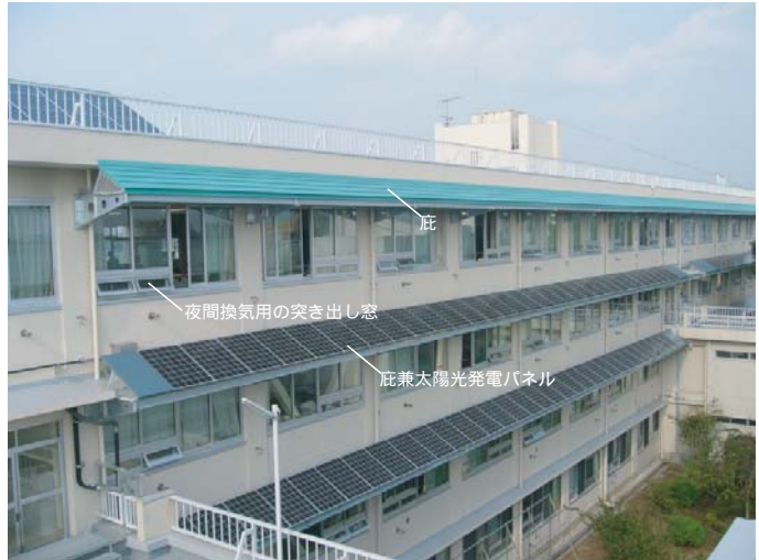
改修後 校舎南側の外観
