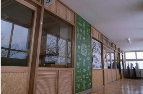
引き戸形式の木製間仕切りに変更。生徒のイラストを入れたサイン、通風を確保するためのガラリなども組み込んだデザイン。
