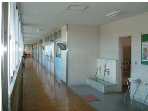
改修前 2階の廊下
