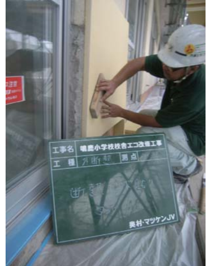
外断熱： 無機質炭酸カルシウムボード貼り。
