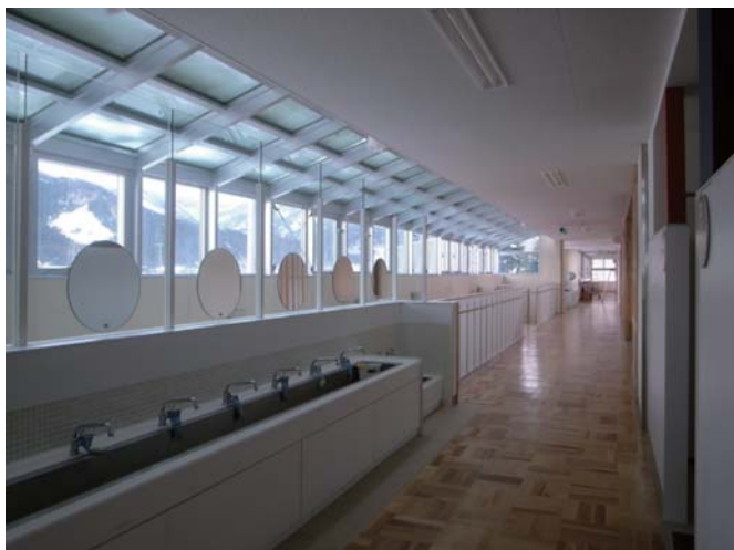
改修後 2階廊下 新しい階段の上部を北向きのトップライトにして光があふれる廊下へ。
