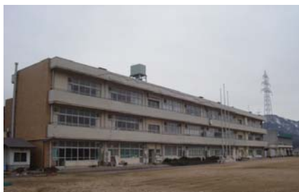
改修前の南側外観
