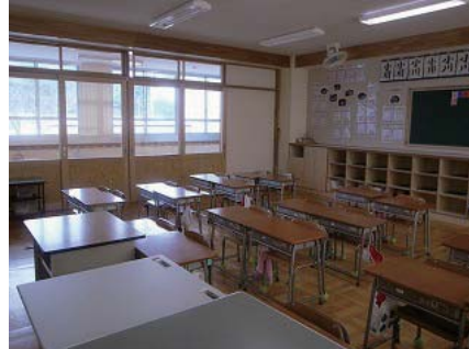
引き戸形式の木製間仕切りに変更。生徒のイラストを入れたサイン、通風を確保するためのガラリなども組み込んだデザイン。
