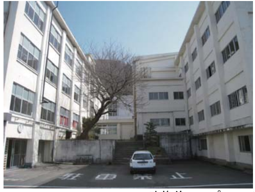
改修前のアプローチ
