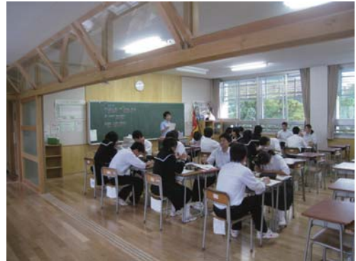
通風促進のために引き戸形式に変更した間仕切りと欄間。
