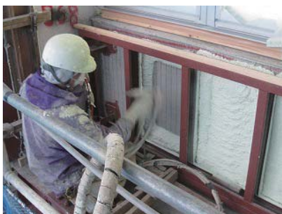
躯体の外側に断熱材を吹き付け外断熱化。
