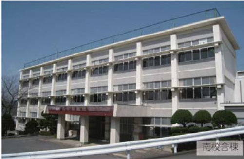
改修前 南校舎の外観
