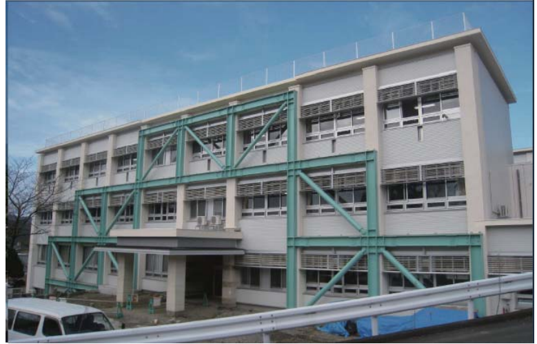
改修後 南校舎の外観 外断熱を施し、日射遮蔽ルーバー、耐震ブレースを設置。
