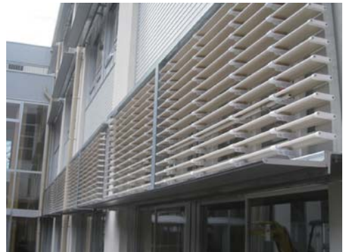
南側窓上部には、新しく日射遮蔽ルーバーを設置。
