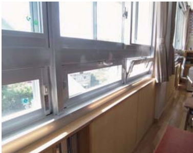
普通教室の南側窓下の腰壁に新しく付けた給気用窓。
